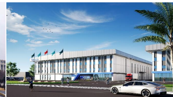
Singapore(建設中) 37,732 m 2
